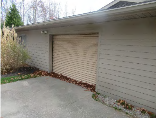
Cart barn overhead door overview
